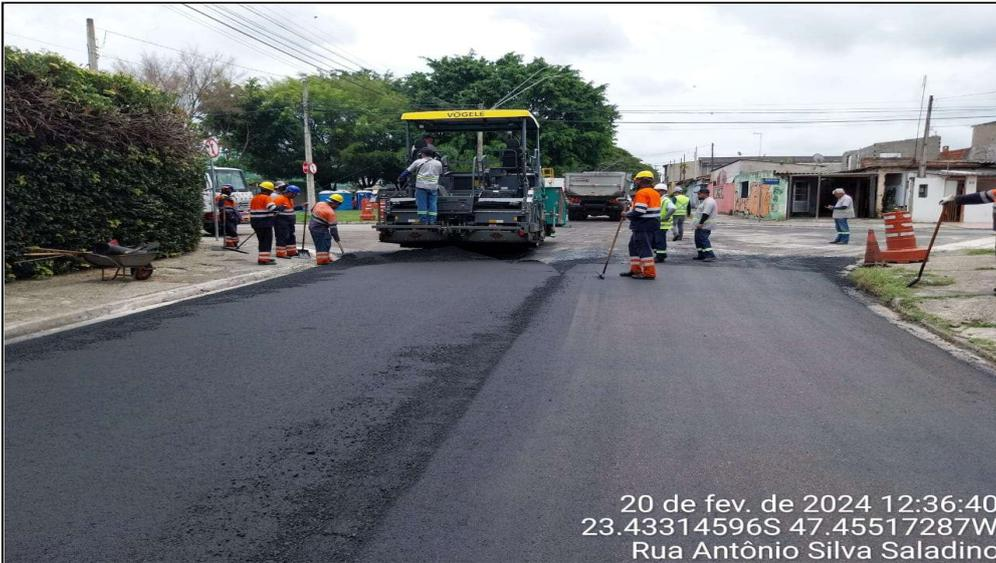
Foto 5 - Execução de aplicação de massa asfáltica
