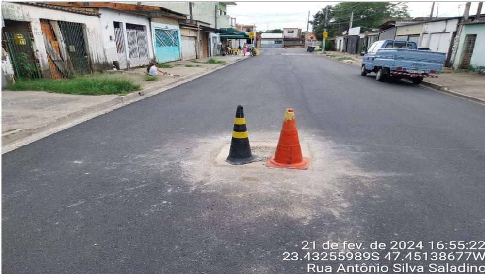
Foto 1 - Execução de nivelamento de PV.
