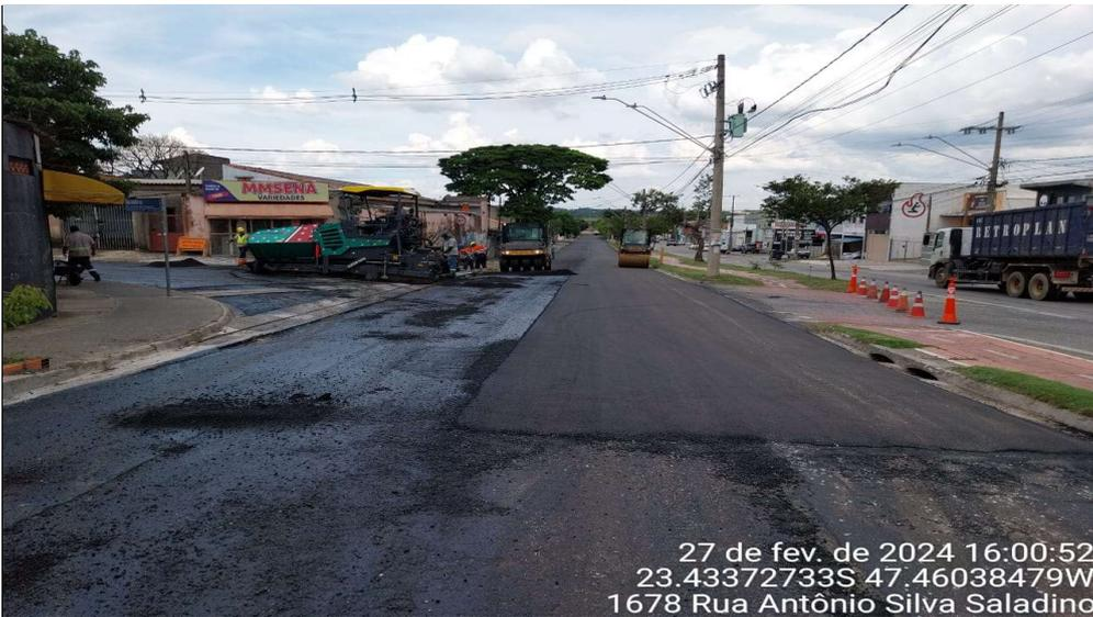
Foto 6 - Execução de aplicação de massa asfáltica
