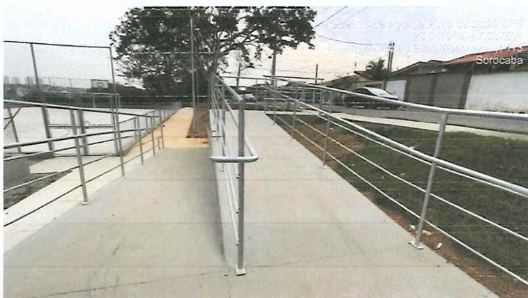
**Foto 4 – Correção de instabilidade dos corrimãos da rampa de acessibilidade.**
